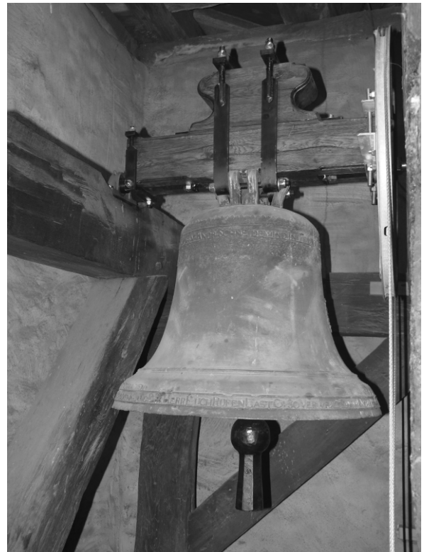
Ev. Auferstehungskirche Darmstadt-Arheilgen, Glocke IV, Johann und Andreas Schneidewind, Frankfurt am Main 1712, „Schlagton“: dis2, Durchmesser: 670 mm, Gewicht: 168 kg
